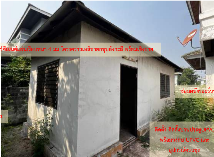
งานติดตั้งฝ้าชายคาไฟเบอร์ซีเมนต์แผ่นเรียบหนา 4 มม โครงคร่าวเหล็ชายกชุบสังกะสี พร้อมเชิงชาย
