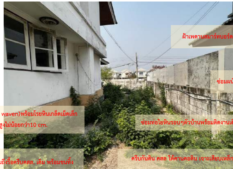
ครีบกั้นดิน คสล ใต้คานคอดิน เจาะเสียบเหล็กด้วยนํ้ายา ตัวบ้านด้านข้าง
