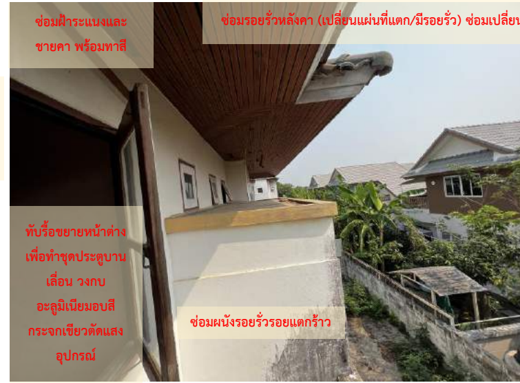
ซ่อมรอยร้าวหลังคา (เปลี่ยนแผ่นที่แตก/มีรอยร้าว) ซ่อมเปลี่ยนแผ่นเชิงชาย พร้อมทาสีหลังคา
