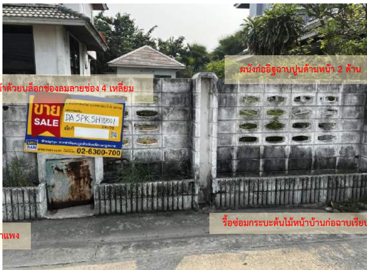
ผนังก่ออิฐกำแพงด้านหน้าด้วยบล็อกช่องลมลายช่อง 4 เหลี่ยม
